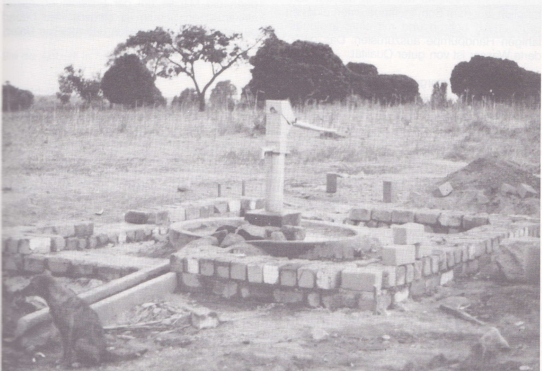
Die neue Wasserpumpe.
